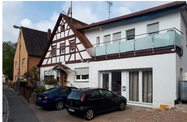
**Abb. 15:** Mischung aus modernem und Fachwerkbau mit Satteldach; giebelständig
