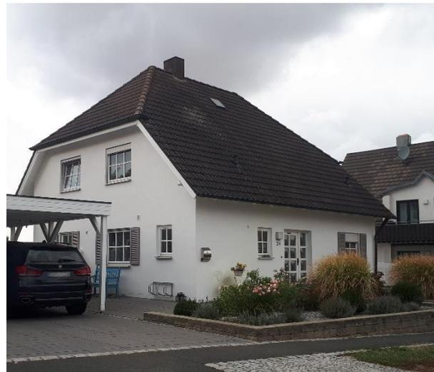
**Abb. 17:** Moderner Bau mit Krüppelwalmdach
