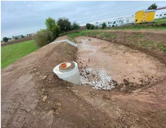
Beim Regenrückhaltebecken Ackerlänge III und IV wurde das bestehende Mönchbauwerk mit einer Lochblende ausgestattet und der Bewuchs entfernt. Es besitzt damit ein Fassungsvermögen von 480 m<sup>3</sup> bei einer Drosselmenge von 45 l/s.
