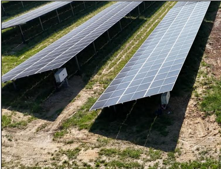
**Abbildung 2:** Anordnung von Wechselrichtern unterhalb der Paneele (Beispiel)
